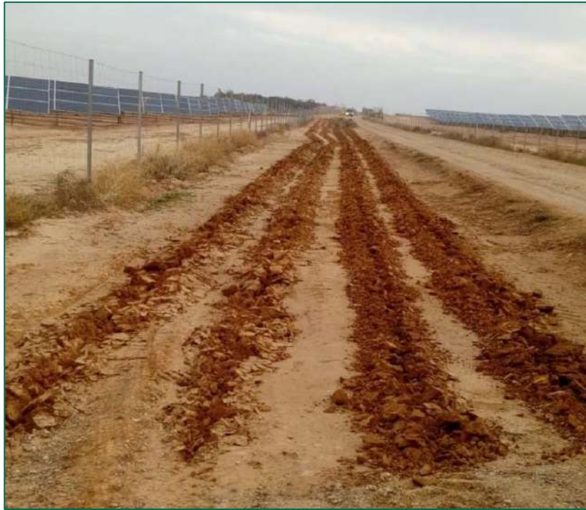
Fotografía 16. Ejemplo de preparación del terreno para la plantación. Fuente: restauración para un proyecto propio
