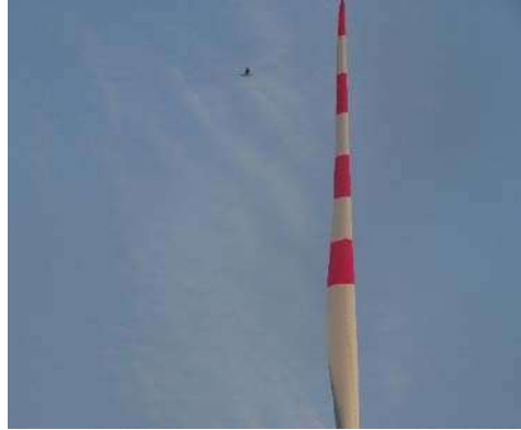
Fotografía 1. Ejemplo de palas pintadas con cuatro bandas rojas en una de las palas del aerogenerador.
